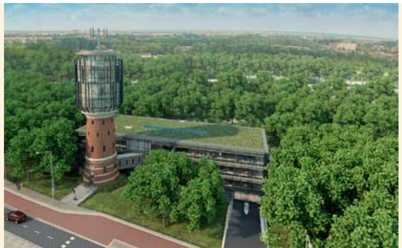
De Bussumse watertoren, het meest duurzame gebouw van Nederland
